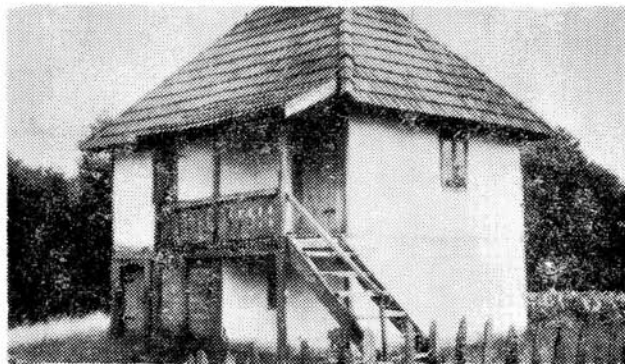
Sl. 3. Kuća na podrum sa zidovima od »brvana« i »šepera« (Donji Pasci, zaselak Kulići)
