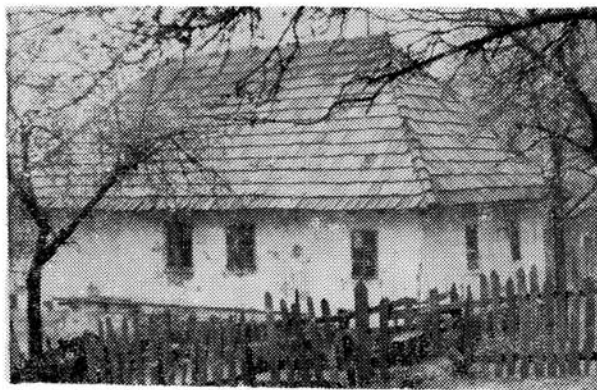
Sl. 2. Višedjelna kuća na podrum sa zidovima na spratu od ćerpića (G. Skipovac)
