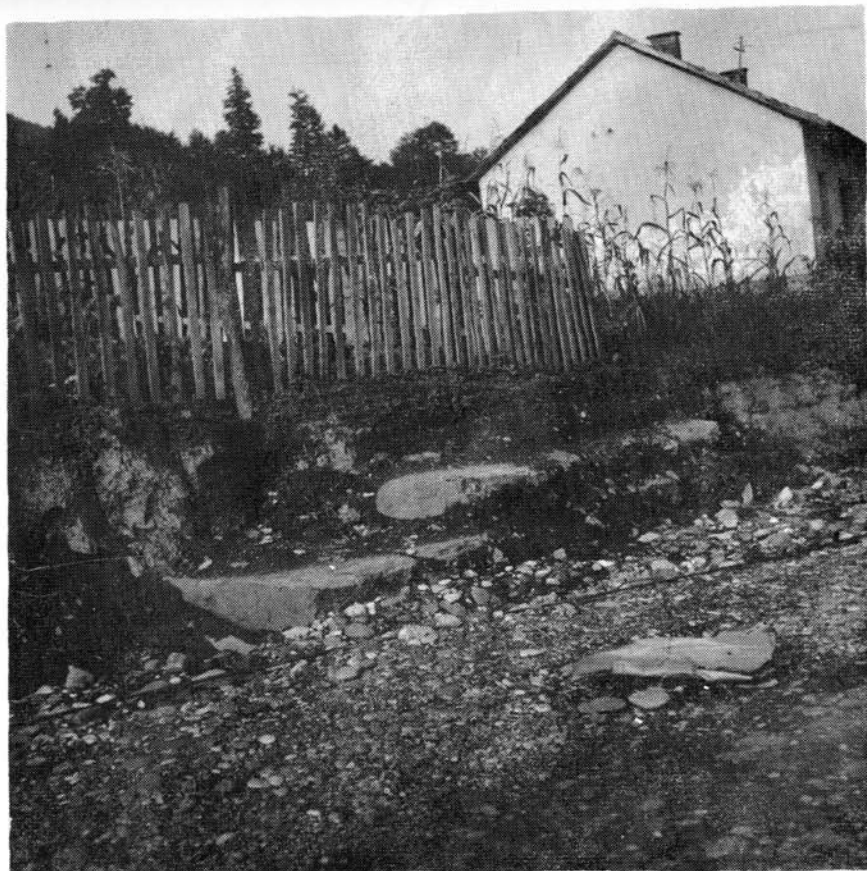
Sl. 1. Neodređeni građevinski objekt u Knežiji (Domavija)
